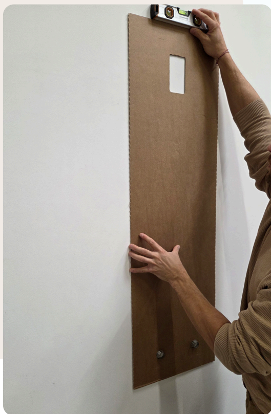
① Positionnement de gabarit et vérification du niveau.
