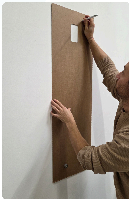
② Marquage des perçages à réaliser.
